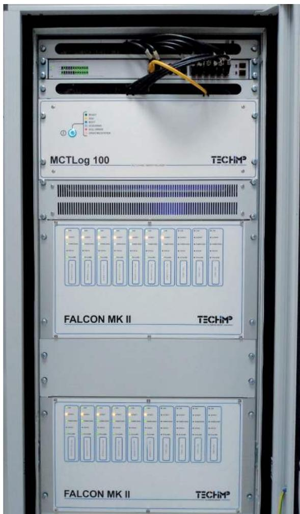
FALCON MKII System est une solution ultime pour la surveillance globale des équipements moyenne tension. Ce système est dédié au suivi d'un groupe d'équipements à grande échelle.
