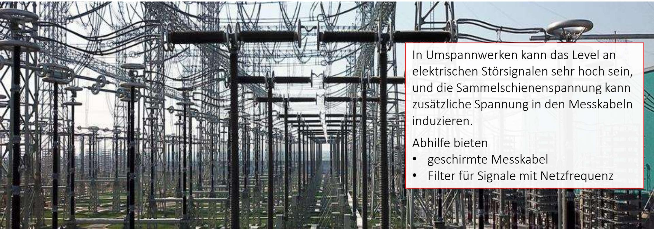
In Umspannwerken kann das Level an elektrischen Störsignalen sehr hoch sein, und die Sammelschienenspannung kann zusätzliche Spannung in den Messkabeln induzieren.
