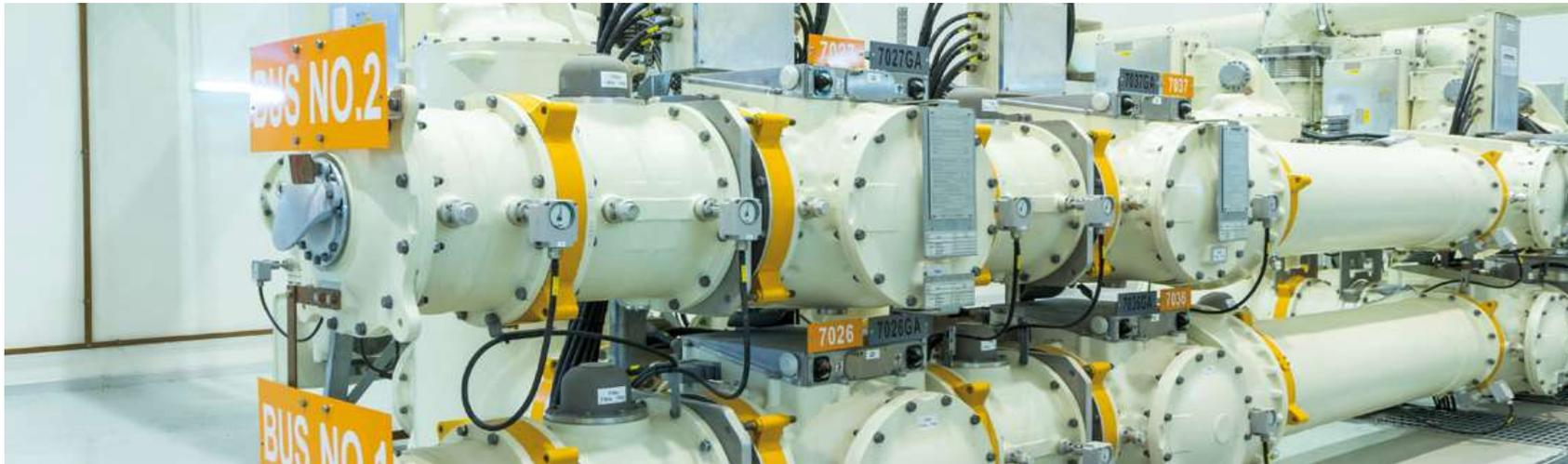
SF6-Gas hat eine 2,5-mal höhere Durchschlagsfestigkeit als Luft und ist in Bezug auf die Lichtbogenlöschung 100-fach effektiver. Dadurch kann der Isolationsraum im Vergleich zu einer luftisolierten Schaltanlage (AIS) um das Zehnfache reduziert werden.
