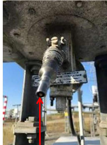
Ventil unter dem Leistungsschalter zum Befüllen mit SF6
