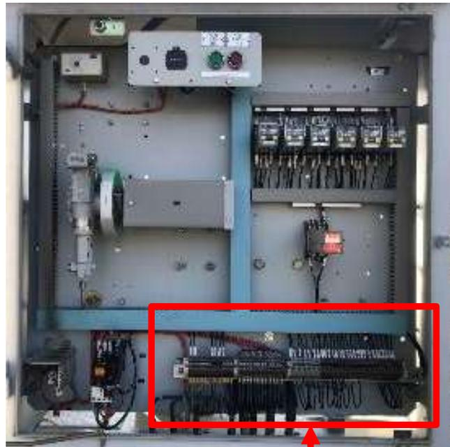
Hilfskontakte für die Spulen-Befehle
